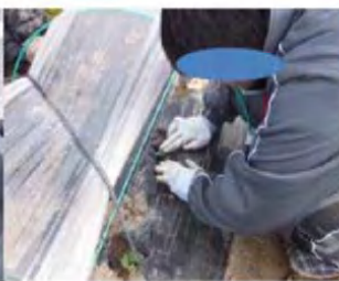
土を鎮圧する
