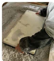
穴あけ版 (PP) を被せてRWをセル底部まで押込む
