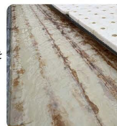
フィルムの設置 フィルム下の気泡を 除いたあとの様子
