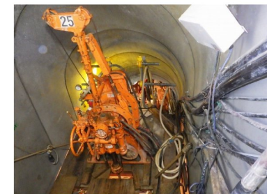
監査廊内カーテンボーリング
