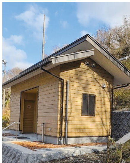
トイレ棟 近景
