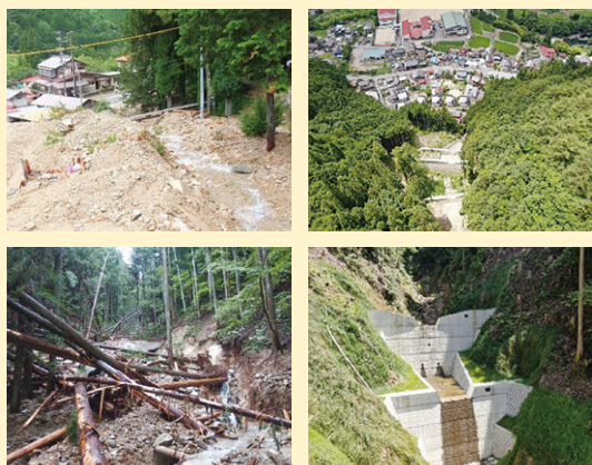
令和2年災害関連緊急治山事業、緊急総合治山事業 下呂市小坂町地内
