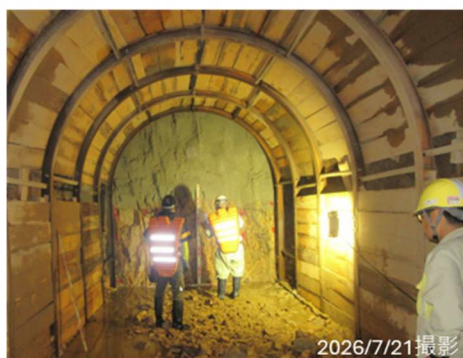
調査坑掘削状況
