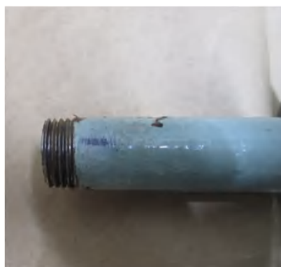
接続部の手入れ後
