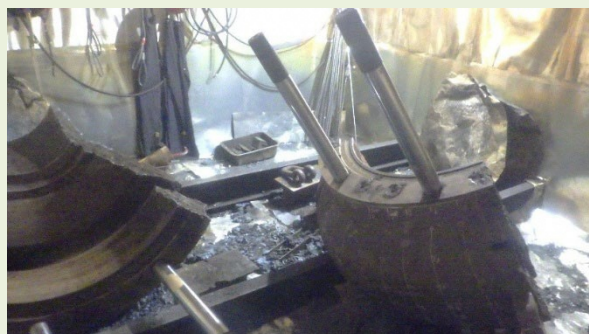
解体中(D号機ケーシング細断状況)
