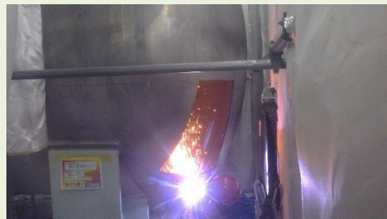
解体中(プラズマ切断)
