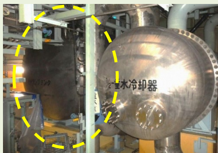
解体前(破線部)
