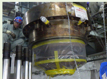
原子炉再循環ポンプの解体撤去 （解体中）
