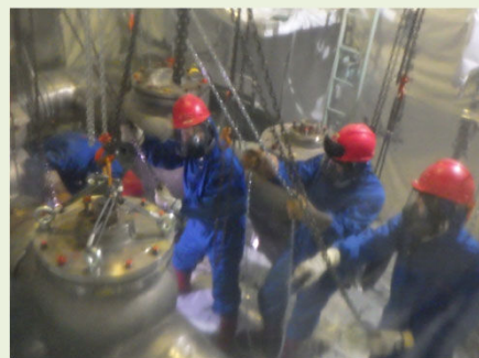
He連通弁廻りの解体撤去 （解体中）
