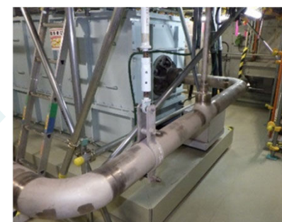
予熱・保温設備（解体後）
