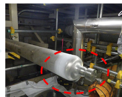
隔離作業後（中間熱交換器入口配管）
