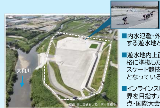
整備事例：大和川保田遊水地
