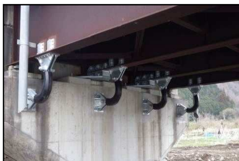
落橋防止装置の設置
