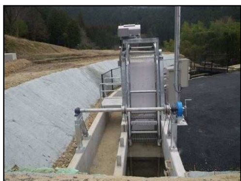
自動除塵機の設置
