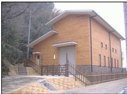
実施後（揚水機場）
