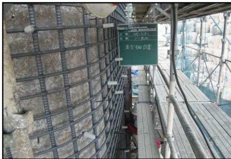
橋脚補強（施工中）
