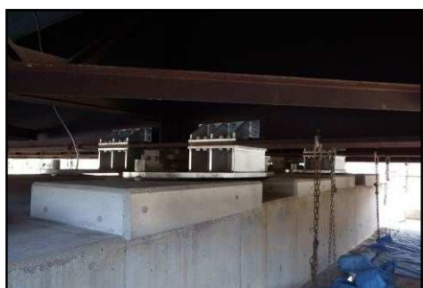
変異制限装置の設置
