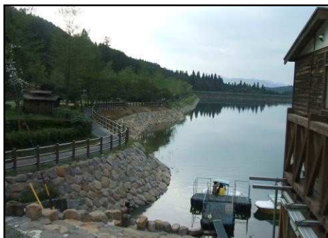
水辺空間整備（護岸工）
