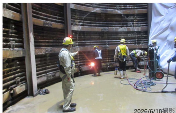
立坑内部から調査坑掘削を開始
