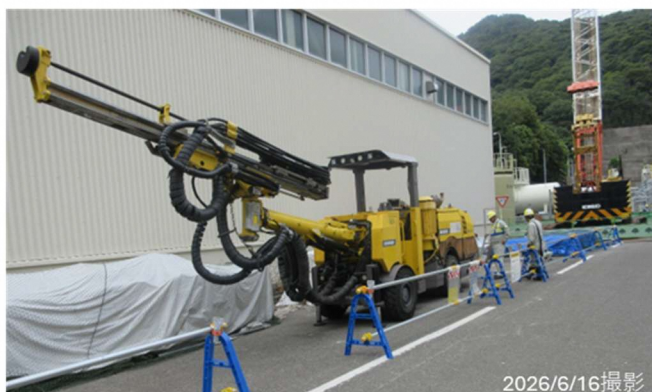
調査坑掘削用ドリル機
