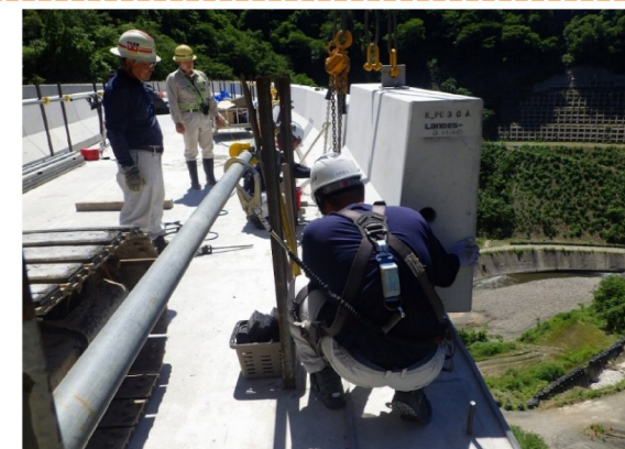
プレキャスト天端高欄据付
