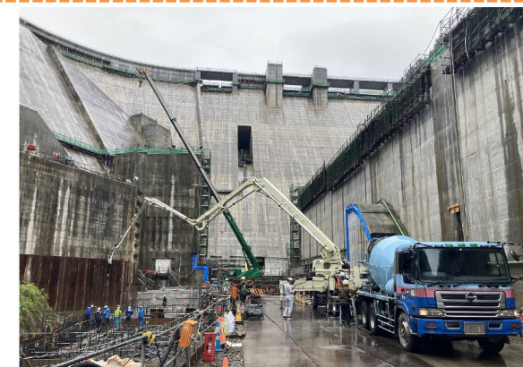
減勢工ポンプ打設
