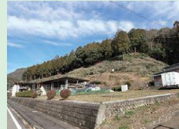
2-② バッファゾーンの整備
