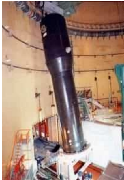
蒸気発生器取替えの様子
