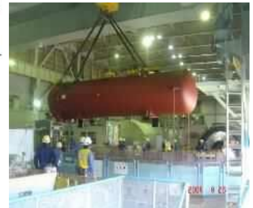
高圧給水加熱器取替えの様子
