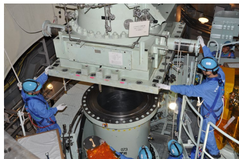
燃料交換装置の復旧
