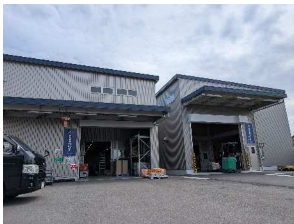
美濃加茂市内で制御盤製作などを手掛ける(株)フジイ
