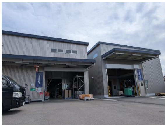
美濃加茂市内で制御盤製作などを手掛ける(株)フジイ
