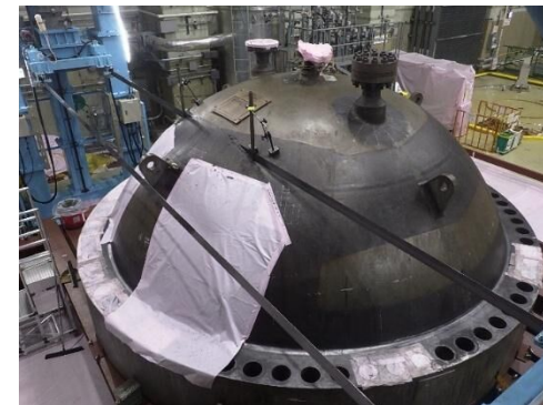
切断作業着手
