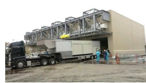
ガスタービン発電機
