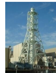
排気筒改造工事
