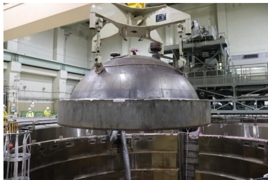
1号機RPVヘッド(取外し中)
