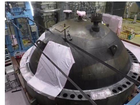
切断作業着手
