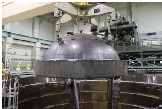
1号機RPVヘッド(取外し中)
