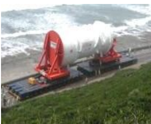
原子炉圧力容器の 陸上輸送の様子
