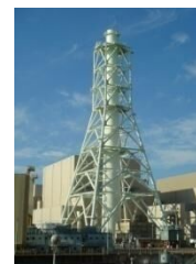
排気筒改造工事
