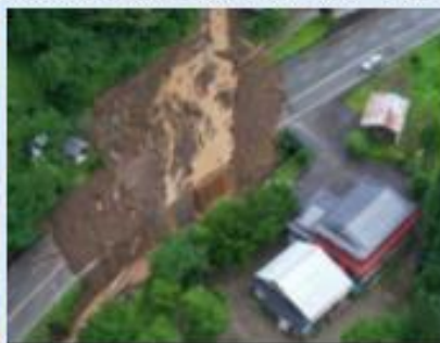
国道158号での土砂災害
