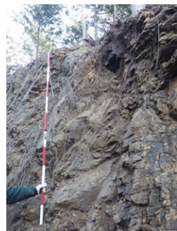
写真2. 切土法面の岩盤
