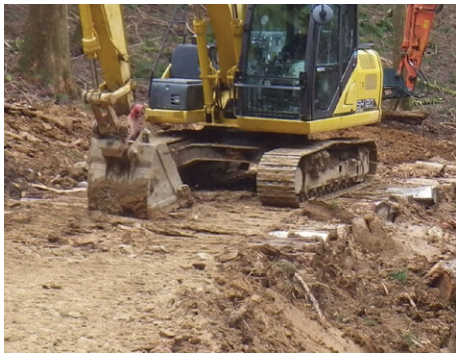
写真1. 軟弱地盤での森林作業道の作設
