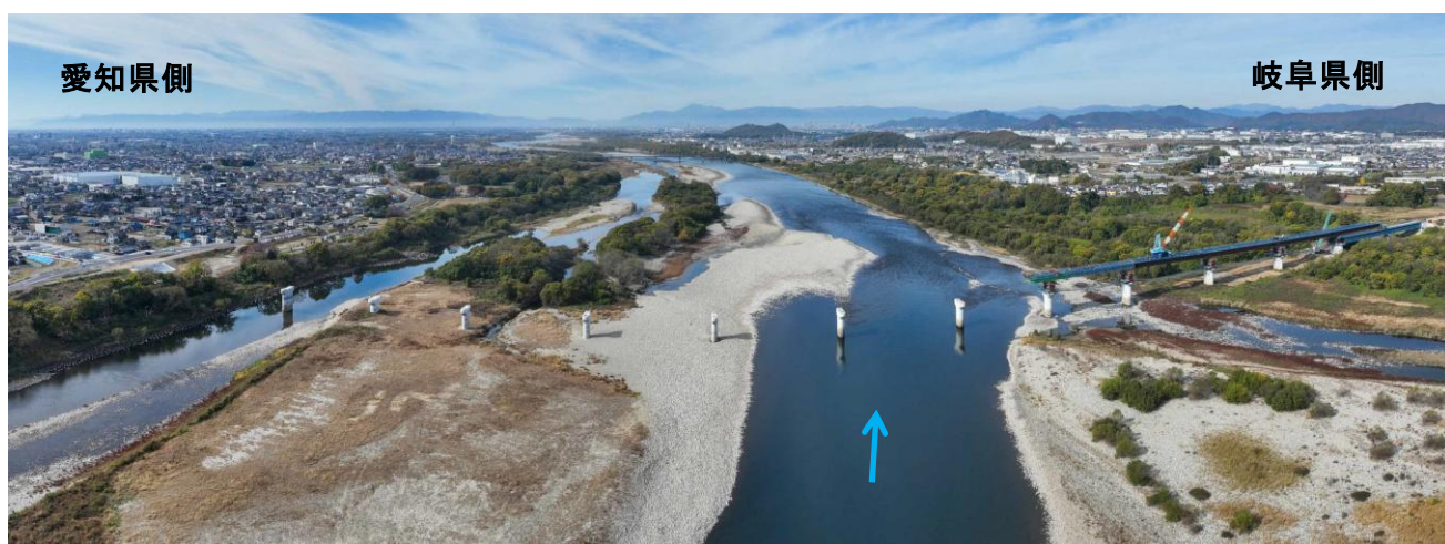
(一) 扶桑各務原線 新愛岐道路 工事状況
