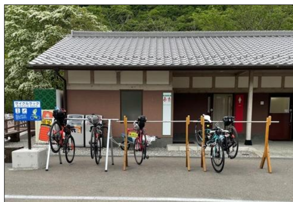
サイクルステーション (サイクリストのための休憩施設)
