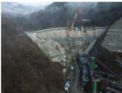
内ヶ谷ダム工事進捗状況 (R7.12時点)
