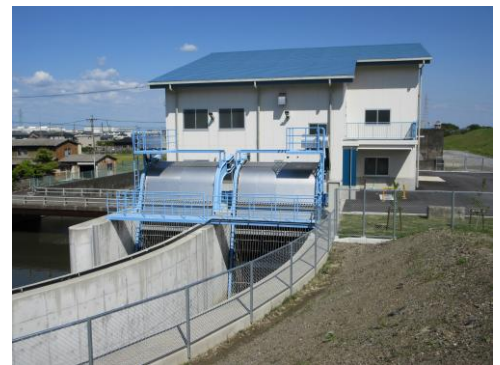
更新した鵜森排水機場(大垣市)
