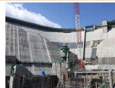
タワークレーン解体
