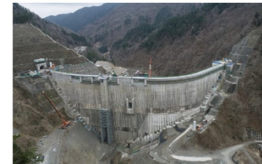
④ ダムサイト状況(上流上空より望む)
