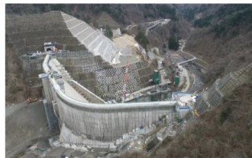
③ ダムサイト左岸状況(右岸上空より望む)
