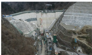
① ダムサイト状況(下流上空より望む)
