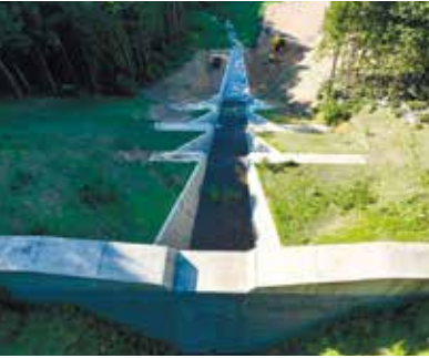
ICT導入で現場作業の効率化・技術向上につながった。
