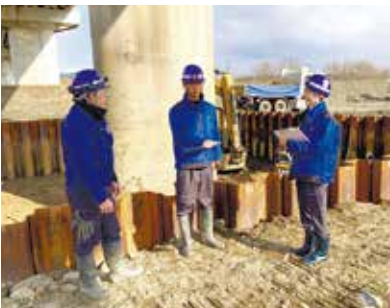
「けんせつ小町」の一環で女性社員も工事現場のパトロールに参加している。
