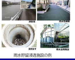
雨水貯留浸透施設の例
