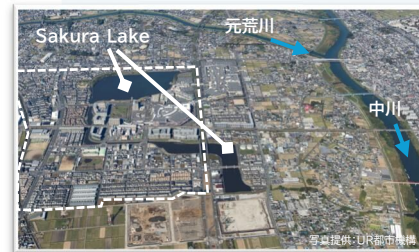
整備事例：埼玉県 Sakura Lake（大相模調節池）
