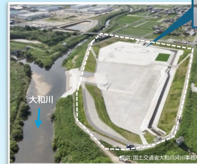
整備事例：大和川保田遊水地
