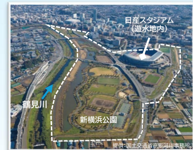
整備事例：鶴見川多目的遊水地
