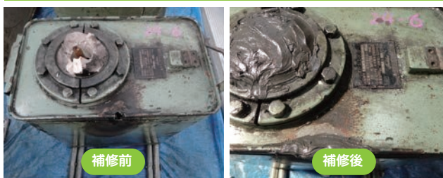
目止め材による補修例
