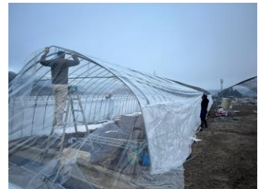
【天井ビニール張り実践指導】
