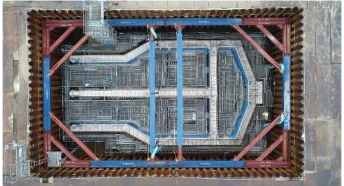
【鋼矢板打設 + 配筋状況写真】
