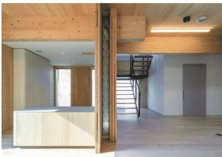
構造にはCLTパネルを採用し、木の美しい表情と強度を両立。
