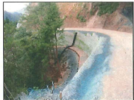
補強土壁工の採用 【縮減額 95,200千円】
