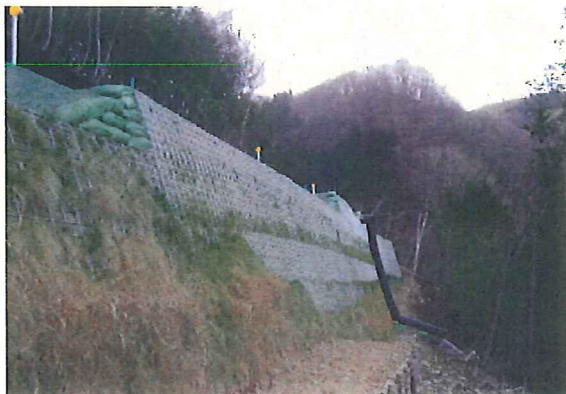
補強土壁工の採用
