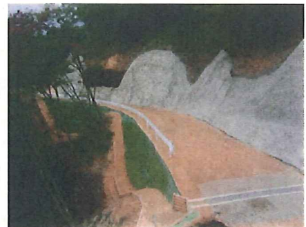
補強土壁工の採用 【縮減額 78,800千円】
