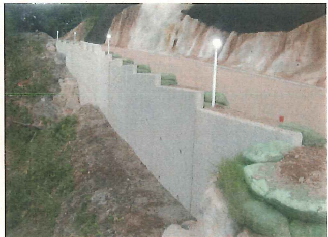
L型擁壁工の採用
