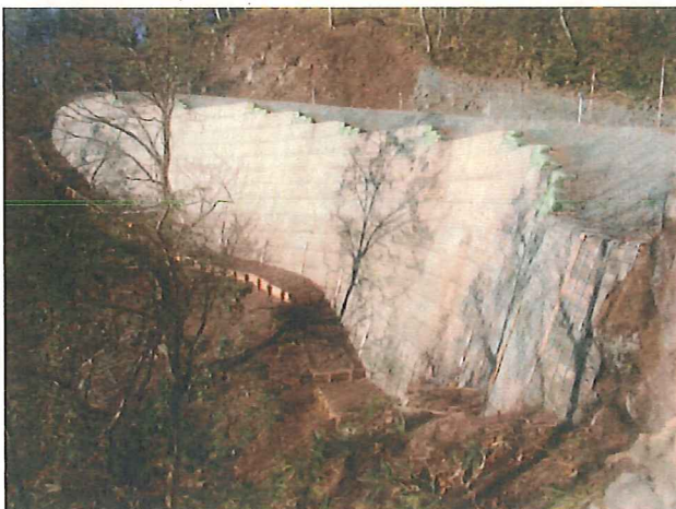
補強土壁工の採用
