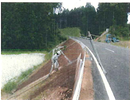
現場発生根株を現場で粉砕し 法面緑化基盤材として利用
