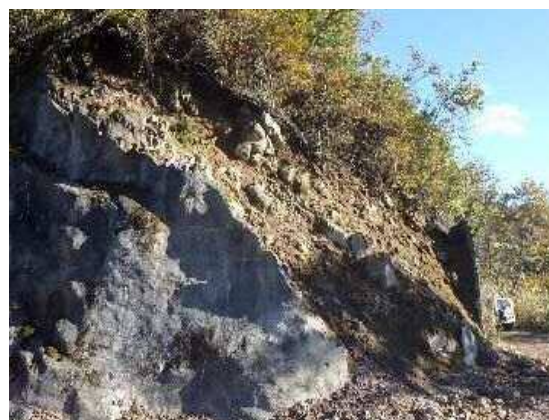
法面崩壊箇所
