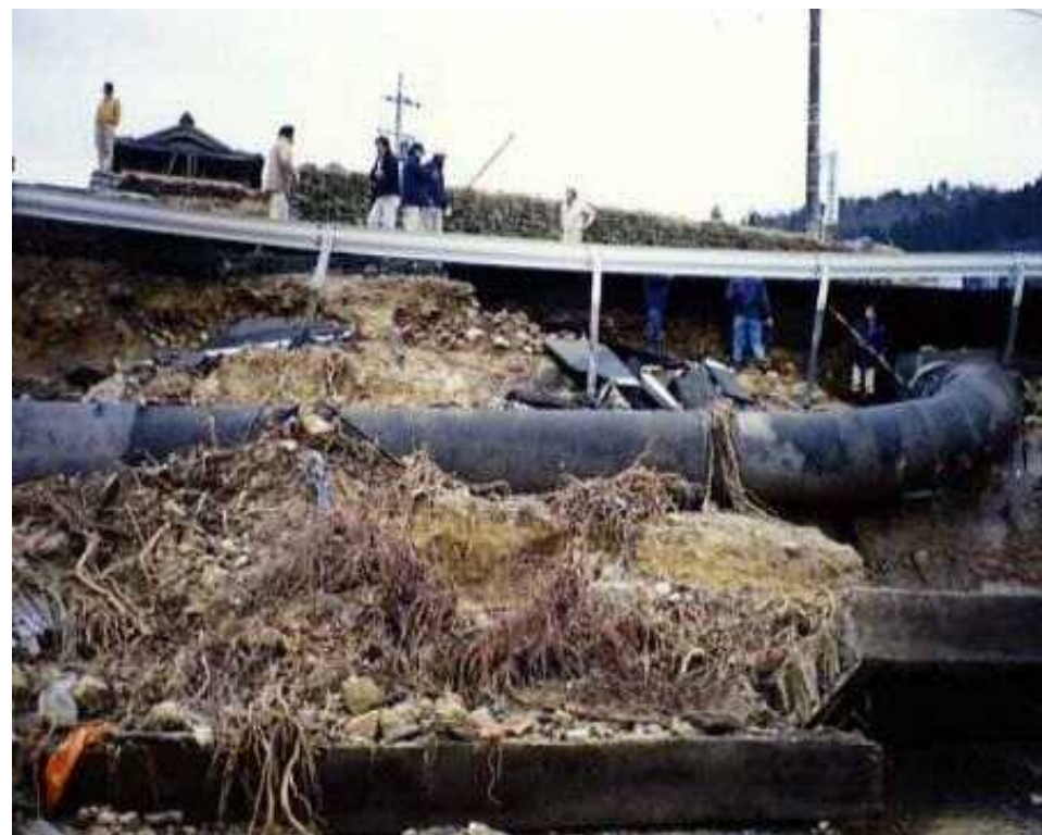
平成6年の水道管破断事故 (瑞浪市)
