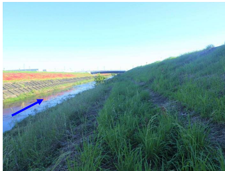
緑化護岸ブロックの客土に現場発生材を使用 (令和6年、植生状況)
