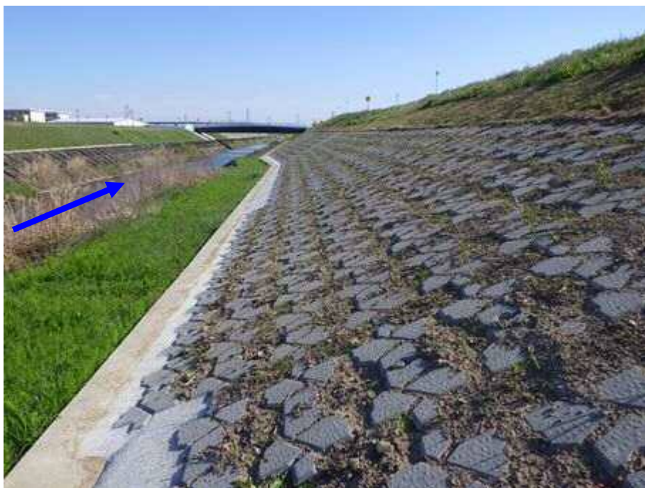
緑化護岸ブロックの客土に現場発生材を使用 (令和元年、施工時点)
