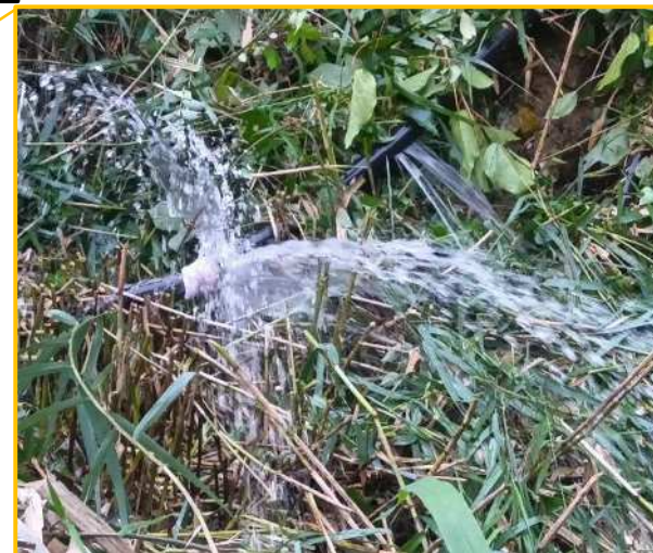
破損してタオルで応急措置状況
