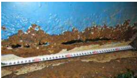
主桁腐食
