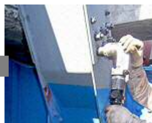
補強板の取り付け
