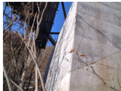
ひび割れ補修後
