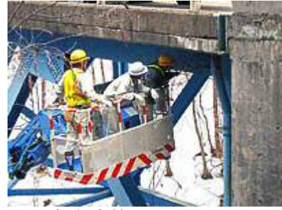
一般交通を規制しての詳細な点検
