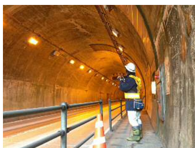
MEによるトンネル緊急点検
