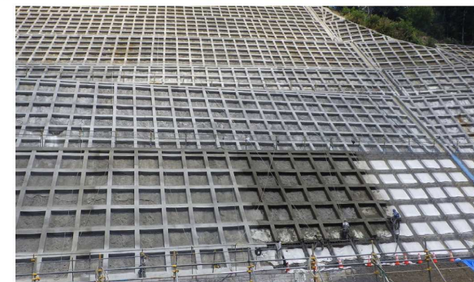
法枠吹付作業
