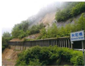
尾神地内 国道156号法面崩壊
