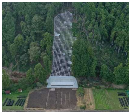
＜被災山林への治山施設整備＞
