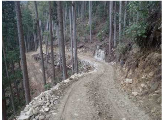
＜森林作業道の整備＞
