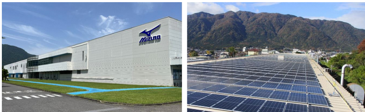
Fig.5 ゴルフ製造棟（左）とゴルフ製造棟に設置した太陽光パネル
