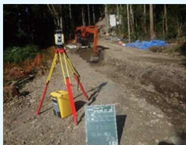
ICT重機による掘削：流路工
