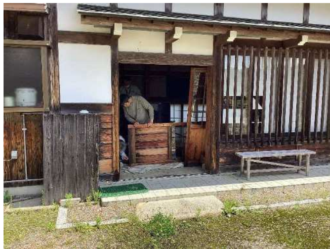
図 4-4-1 家屋修繕の様子
