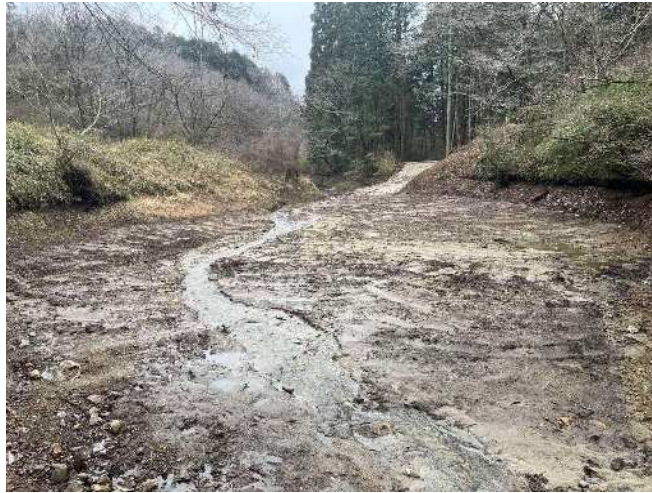
図 4-2-1 神田川堰堤付近浚渫後の状況（2025 年 3 月 25 日）
