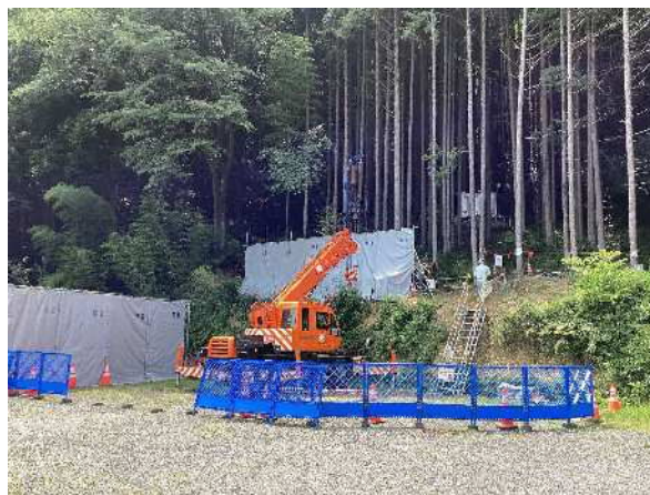
図 4-1-3 深井戸設置工事の様子
