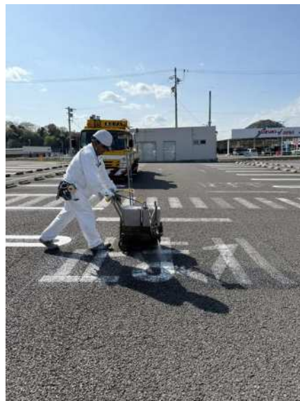
道路の案内標識の工事を行う 従業員
