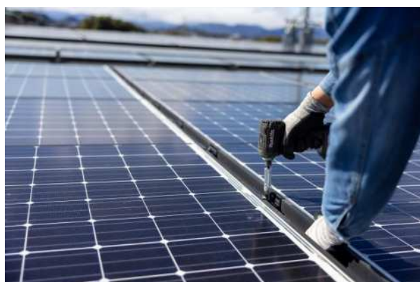
屋根板工事の技術が同社の強み
