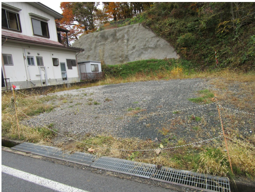
物件南西方向から撮影
