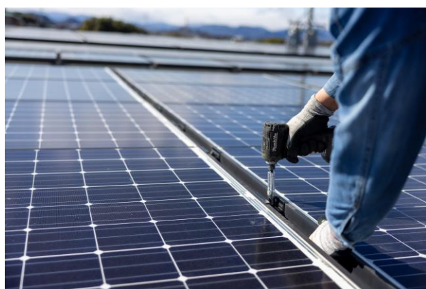
屋根板工事の技術が同社の強み
