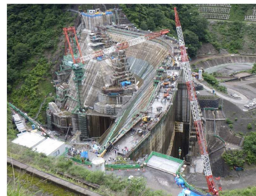
堤体コンクリート打設(タワークレーン+クロールクレーン)
