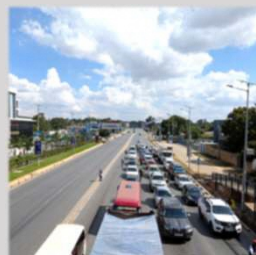
車通りの多い整備された道
